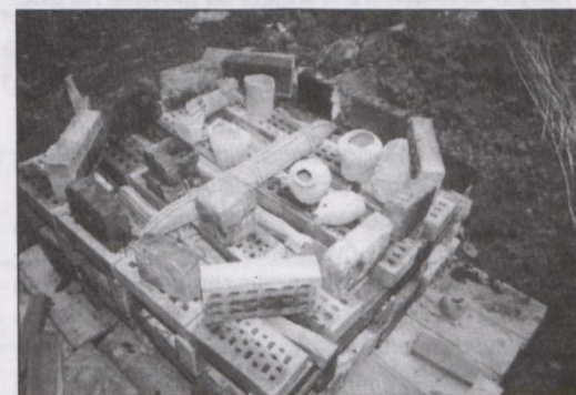
Budowa pieca węgierskiego (wypal ceramiki) – Kazimierz Dolny – fot. B. Żukowski
