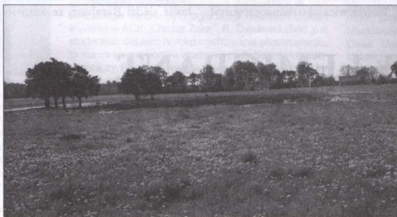
Fot. 1. Rejon LZW, pole górnicze. Nadrybie, kształtująca się, zawadniona niecka osiadania na polu uprawnym. Fot. F. Świąś, IV. 2000 r.
