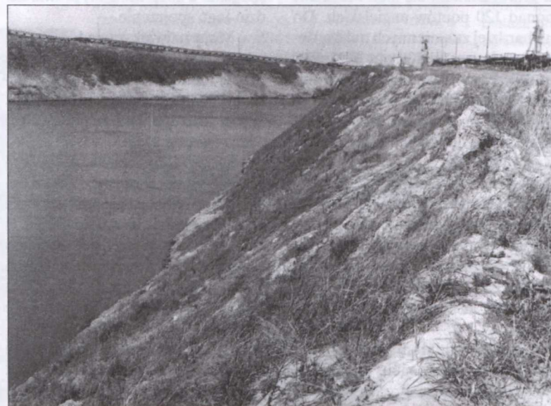
Fot. 2. Rejon LZW, Bogdanka. Zbiornik zrzutu wód kopalnianych we wnętrzu hałdy. Fot. F. Świąś, VII. 1995 r.
