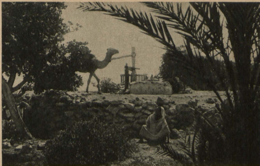
Marok — t. zw. „noria”, służąca do wyciągnięcia wody ze studni
