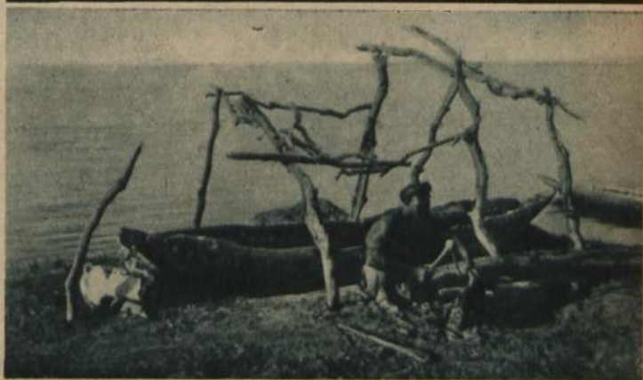
budowa pirogi „szytej”
