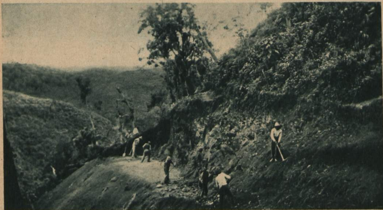
Budowa drogi na kolonii Marquez de Abrantes — Brazylija
