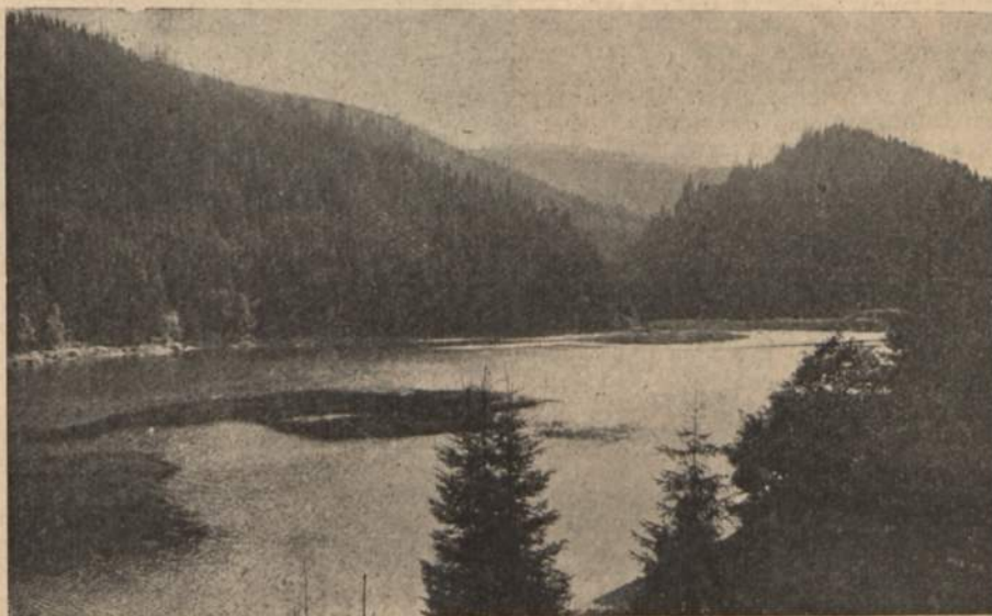
Klauza Szybenka po spuszczeniu wody.
