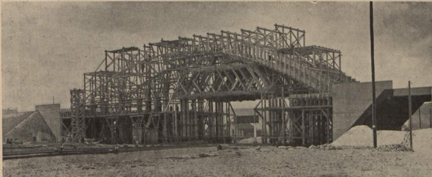
Gdynia. Budowa wiaduktu nad torami kolejowymi na molo Węglowem. Wiadukt ten uniezależni ruch kolejowy między portem i miastem od ożywionego w tym miejscu ruchu kolejowego. Cała konstrukcja wiaduktu zbudowana będzie z żelazobetonu.
