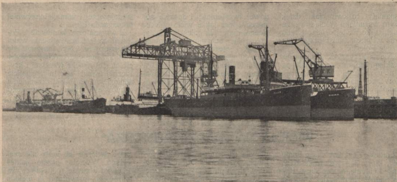
Urządzenia do przeładunku węgla f-my „Polskarob” na nabrzeżu Szwedzkim w Gdyni. W środku wywratnica wagonowa. Zdjęcie Urzędu Morskiego
