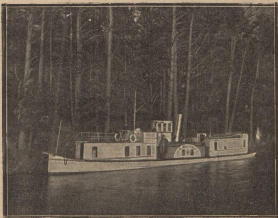
Łódź parowa „Emilia Plater” na wododziałowym stanowisku kanału Augustowskiego.
