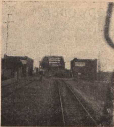
Wjazd na most na Wiśle w Grudziądzu.
