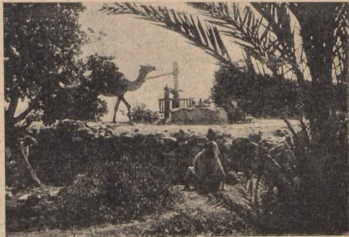
T. zw. „norija”, służąca do wyciągania wody ze studni.
