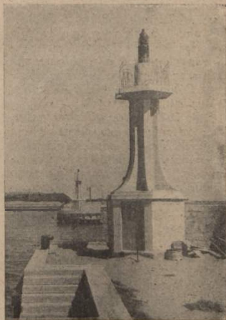
Latarnia wejścia północnego i do basenu południowego
