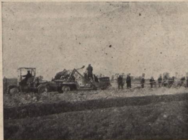
Układanie kabla
