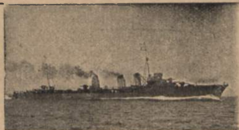
KONTRTORPEDOWIEC „TIGRE” (36,7 węzł.) — NAJSZYBSZY OKRĘT TEJ KLASY W ŚWIECIE. (Atel. et Chant. de Bretagne).
