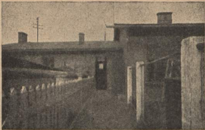
Dworzec kolejowy dawny.
