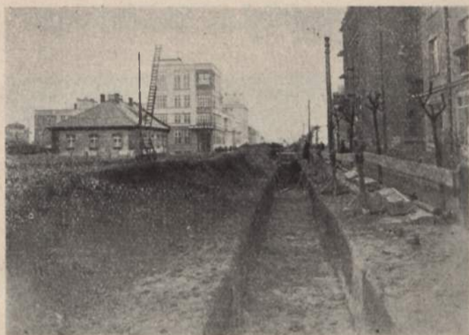
Gdynia. Budowa kanału deszczowego na ul. 10 Lutego.
