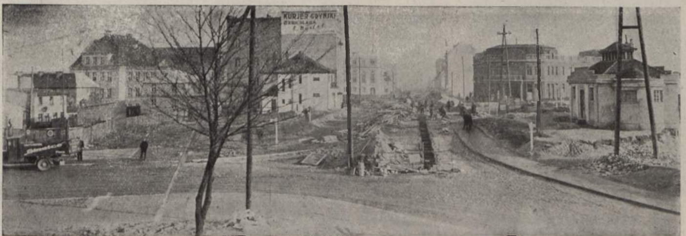
Roboty kanalizacyjne na ulicach Gdyni. Ul. 10 Lutego w pobliżu tunelu kolejowego.
