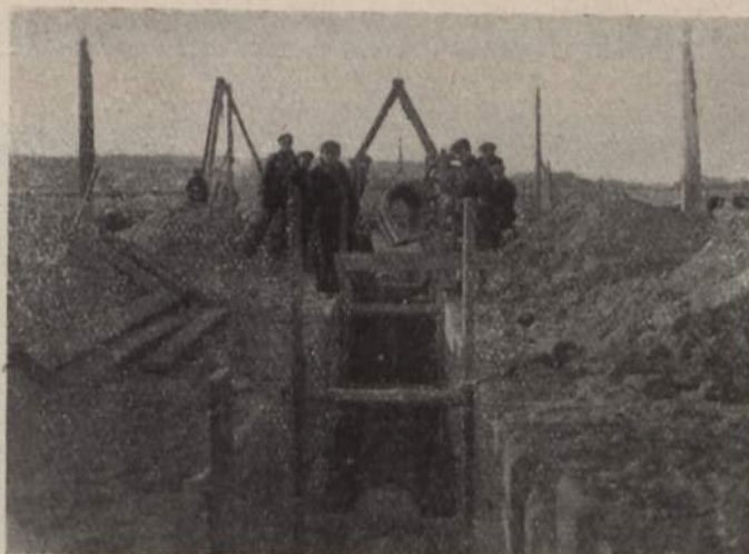
Gdynia. Budowa kanału, odprowadzającego wody z Imhoffu na dno morza.
