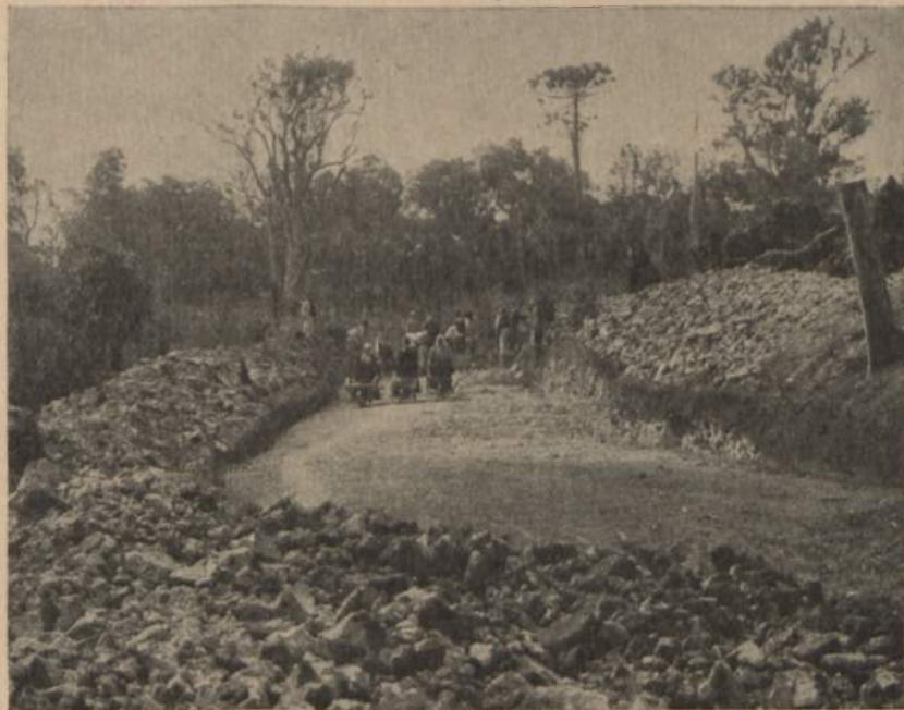
Kolonistki polskie przy budowie drogi do kolonji.
