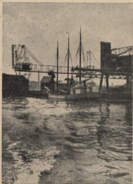
Dźwigi portu szczecińskiego.
