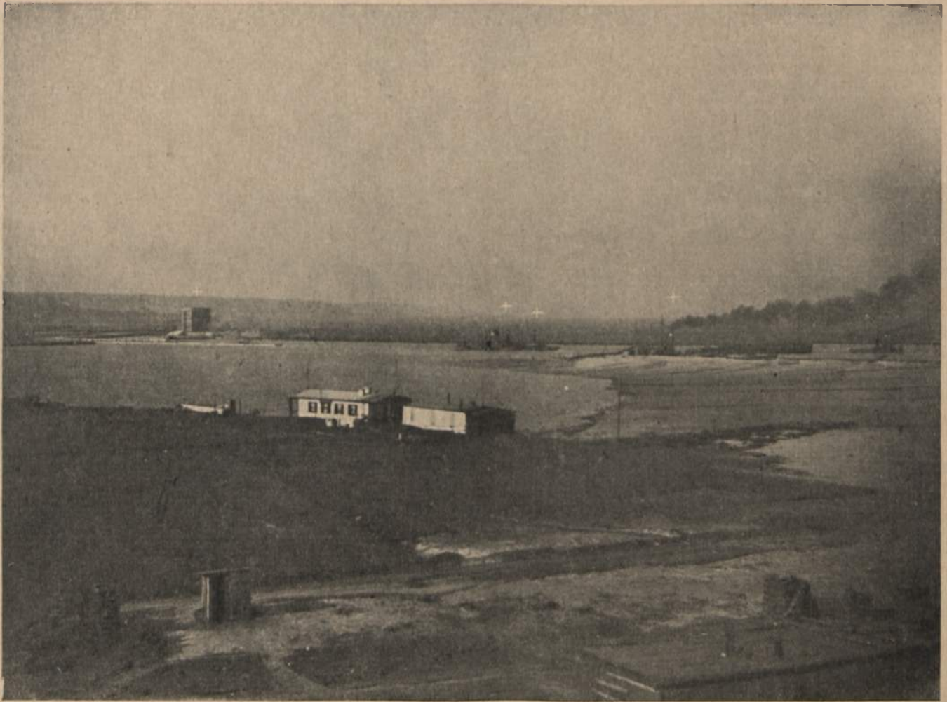
Przy budowie portu w Gdyni wre wytężona praca. Trzy drągi pogłębiają basen wewnętrzny portu, by umożliwić wielkim transportowcom dojazd do nadbrzeży, przy których stanął nowowzbudowany 5-piętrowy gmach łuszczeni ryżu (na lewo, oznaczony krzyżykiem). Fot. E. Skrzypczak.
