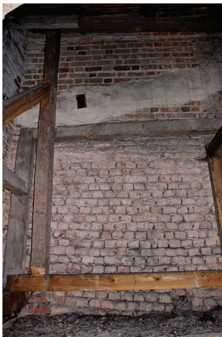
Ilustracja 8. Kościół farny we Wrześni – widok z poddasza obecnej zakrystii na zamurowane przezrocze empory, fot. M. Potocki (2009)
