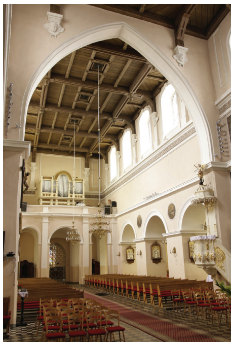
Ilustracja 3. Kościół farny we Wrześni – widok wnętrza ku zachodowi z prezbiterium, fot. M. Potocki (2009)
